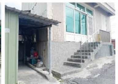
■ 低落差大的鄰棟建築
