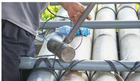
■ 利用鐵鎚使力將塑膠繩綁得更緊。
